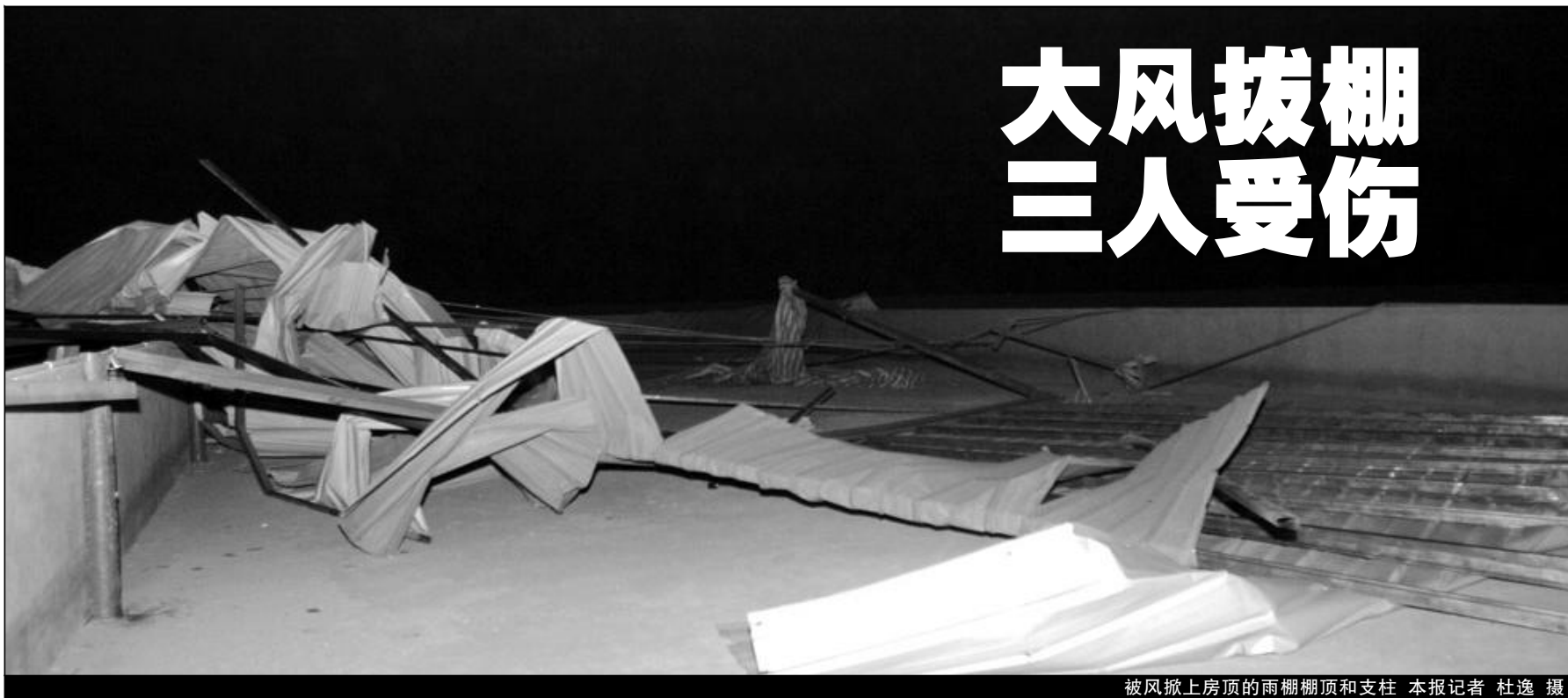
被风掀上屋顶的雨棚棚顶和支柱 本报记者 杜逸 摄
